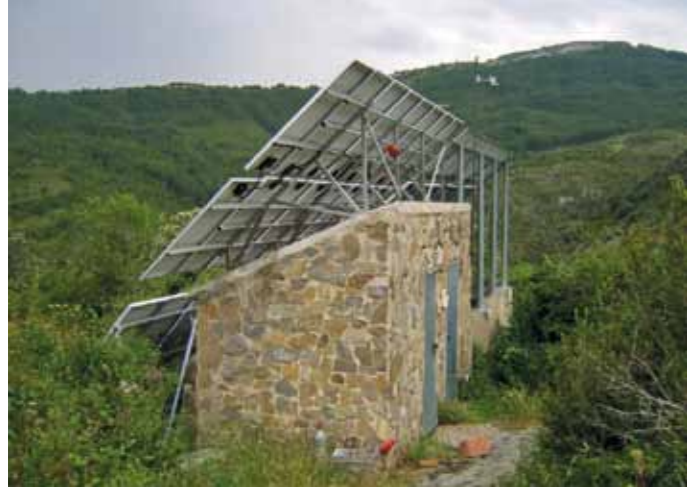
Instalación termosolar en Lakabe.
