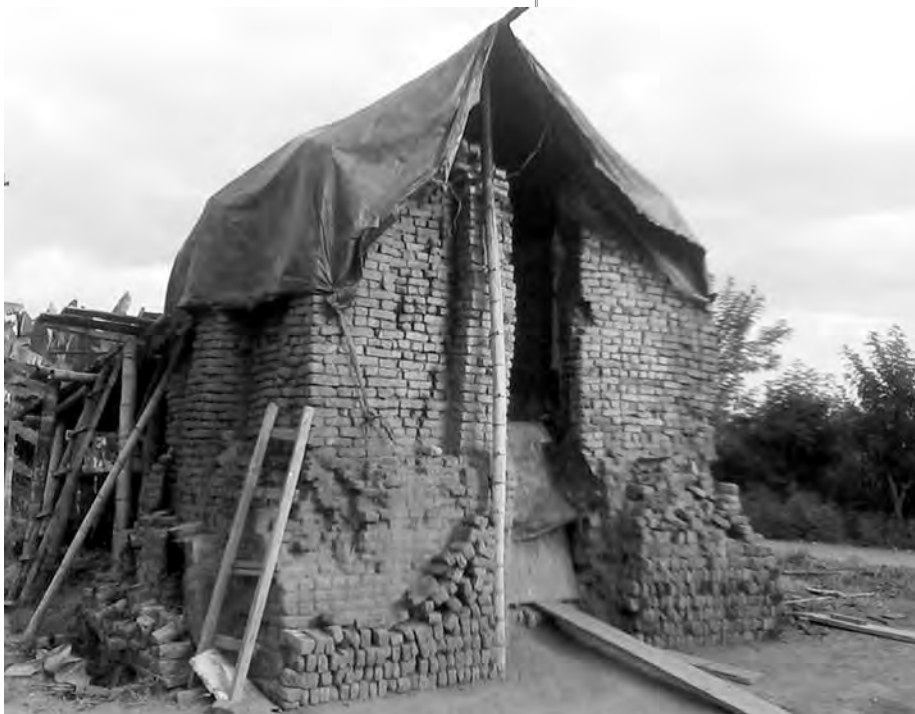
Pila de ladrillos.
