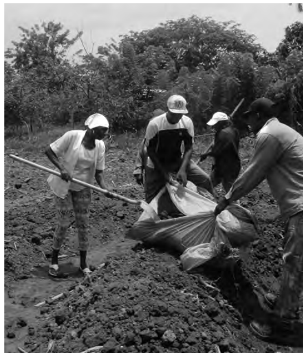
Construcción huerto circular.
