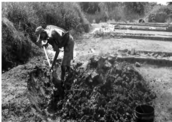
Producción artesanal de material de construcción.
