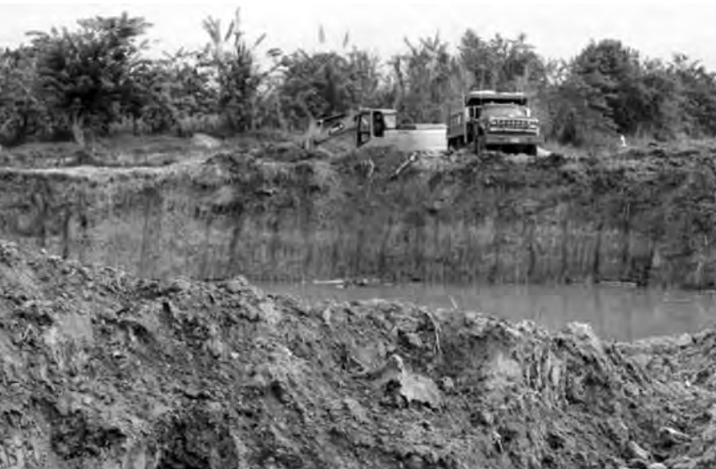
Excavaciones. Vereda Caponera, Guachené.
