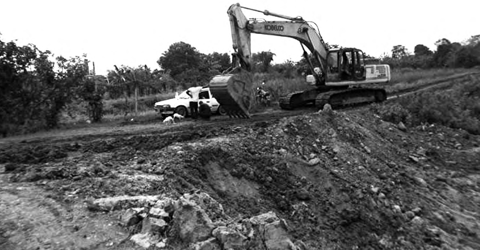
Maquinaria para extracción de arcilla.
