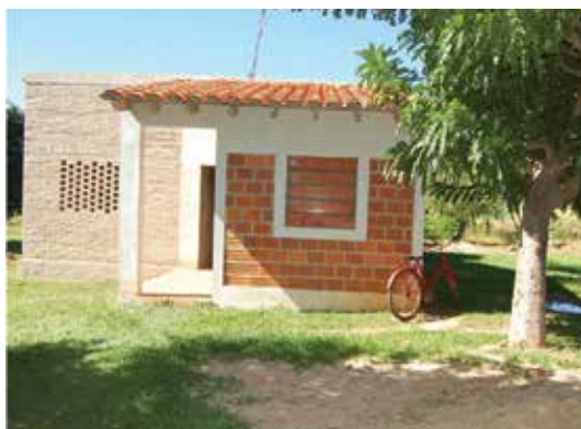
Vivienda del Asentamiento, apoyada para el mejoramiento por Programa de SENAVITAT.
