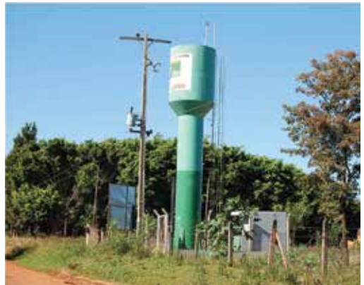
Tanque de agua colocado en Primera Línea en el dad local último año 2012
