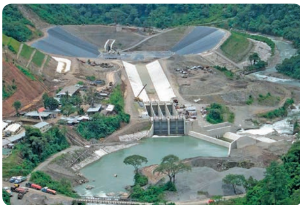
FOTO 3. Hidroeléctrica Xacbal, Quiché
