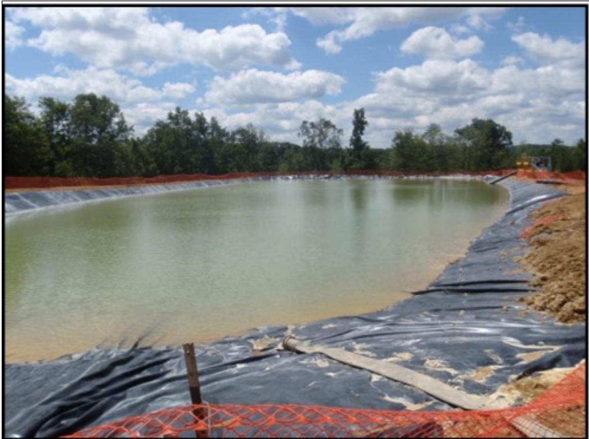
Membrana que separa el agua contaminada utilizada en el *fracking* de la tierra. Fuente: ALL Consulting 2008
