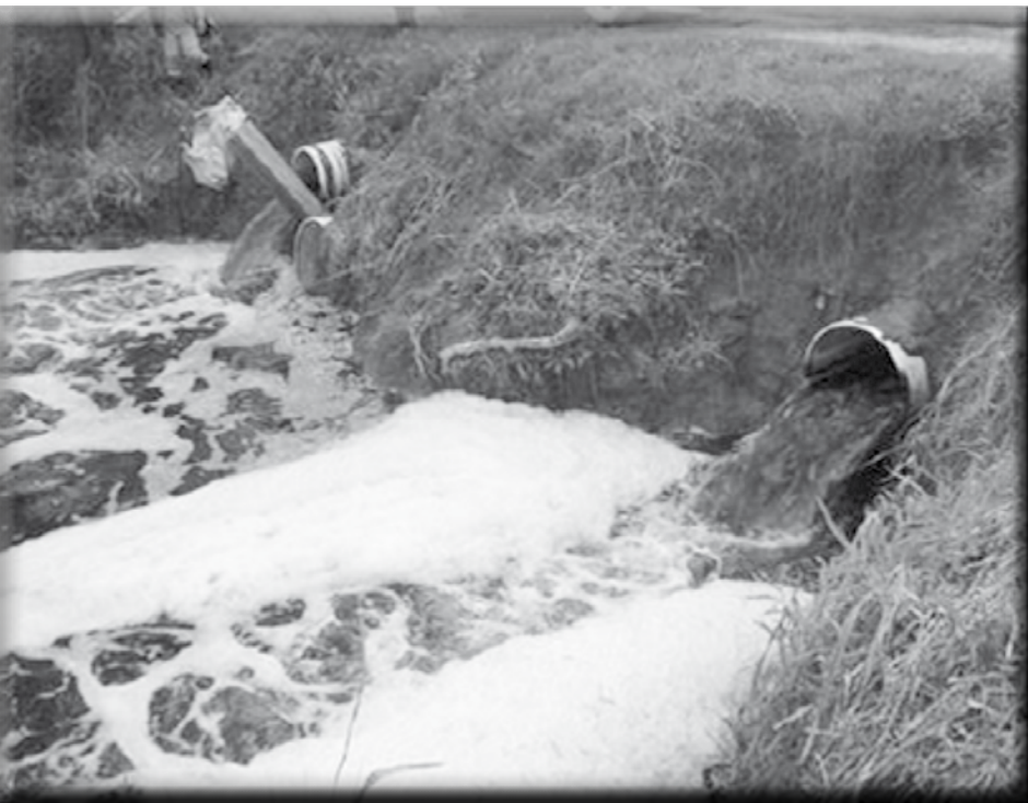
Canalización de caños y contaminación hídrica en la zona de Las Pavas.
