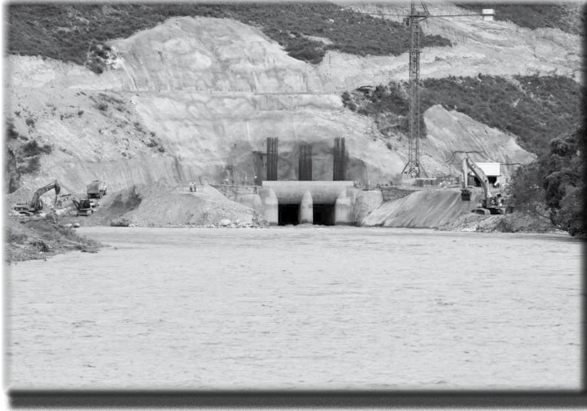
Desviación de Río Magdalena para hidroeléctrica
