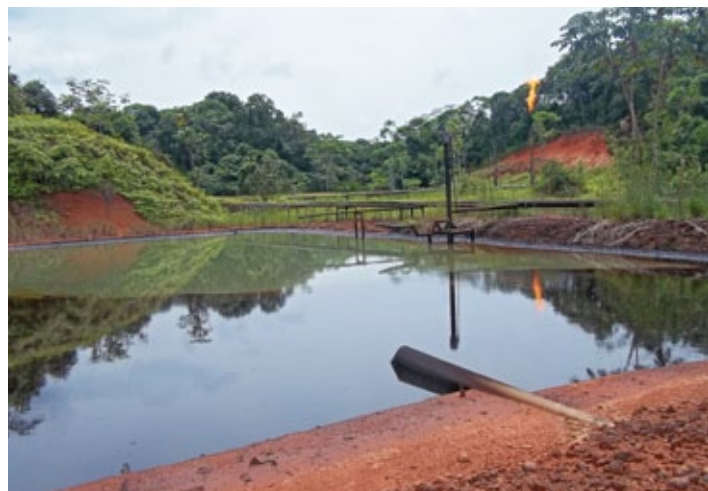
Foto1: Laguna de oxidación sin recubrimiento, ni geomembrana.
