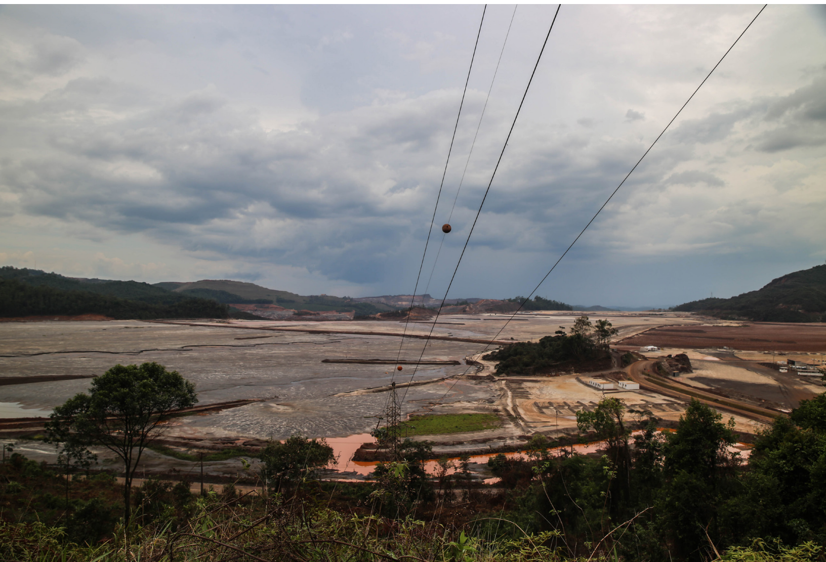
Barragem de rejeitos de Germano
