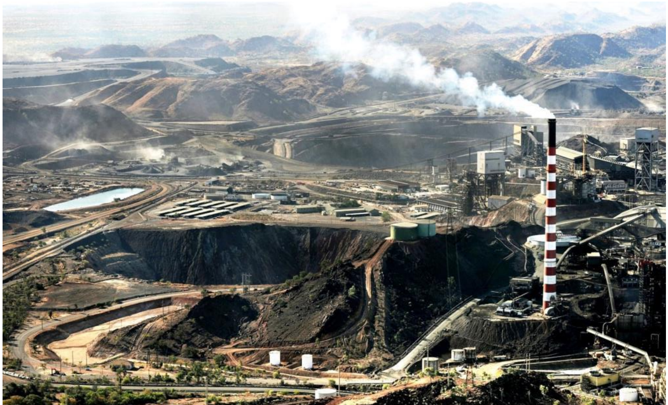
3. Fundición de Cobre en Indonesia. Los fundidores suelte venenos mortales en el aire, el suelo y el agua.
