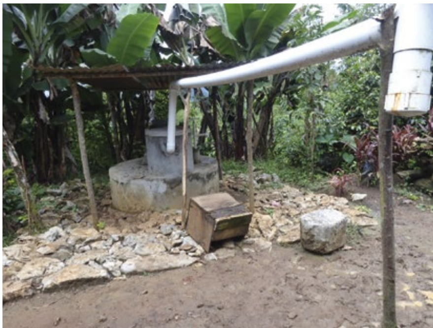
Depósito de agua de lluvia en una vivienda familiar. Comunidad de Xicacao, San Pedro de Carchá. Noviembre 2014.
