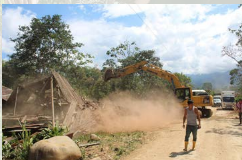
Maquinaria destruyendo las viviendas locales durante los desalojos forzados (Fotografía: CONAIE)
