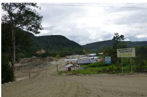
Campamento para construcción de infraestructura para el proyecto minero (Fotografía: Acción Ecológica)
