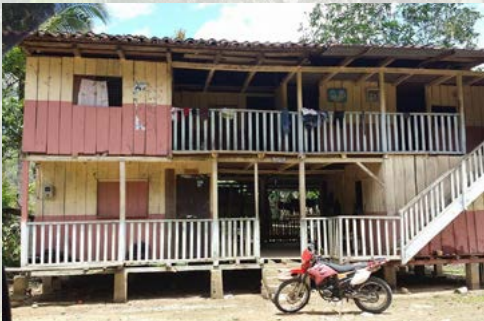
Vivienda de una familia local antes de ser derrocada (Fotografía: CASCOMI)
