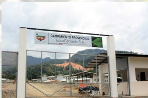
Acceso al campamento minero de la empresa Ecuacorriente S.A. en la Vía El Cóndor y puesto permanente de seguridad (Fotografía: Plan V)
