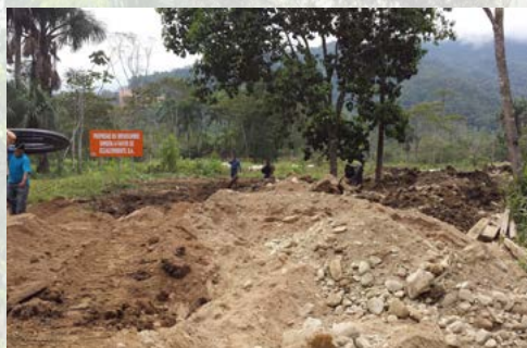
Familias cargando tubos de agua tras el derrocamiento de las viviendas (Fotografía: CASCOMI)
