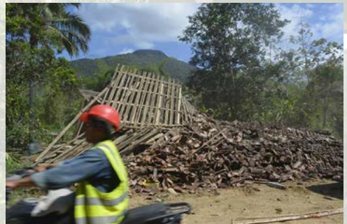
Viviendas derrocadas tras los desalojos forzosos (Fotografía: CASCOMI)
