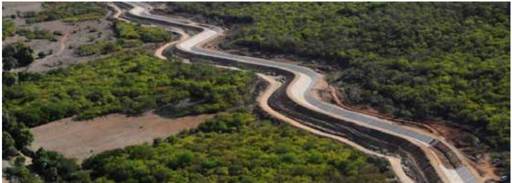
Figura 4 – Obras de transposición del Río San Francisco. Obras de transposición del Río San Francisco.
