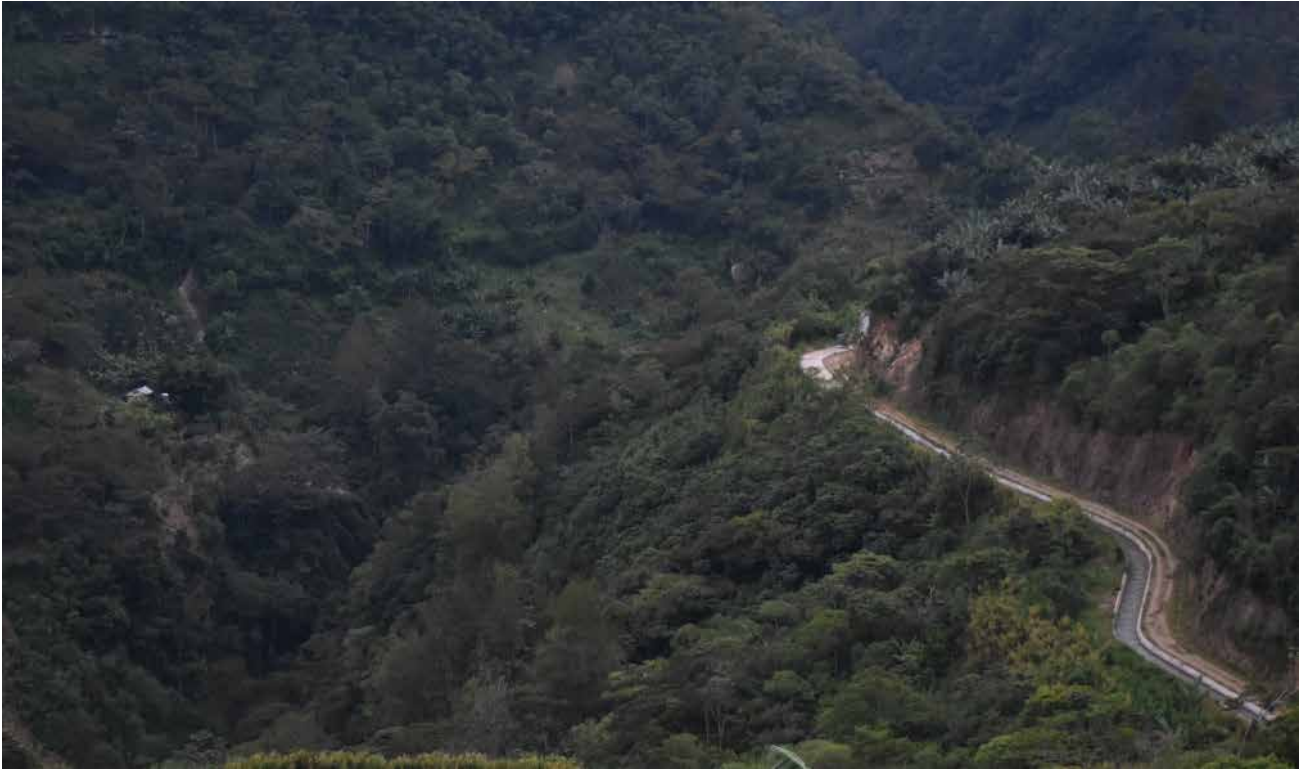
Canal de presa hidroeléctrica Aurora I, la concesión de este bien común es por 30 años a la empresa Inversiones La Aurora S.A. de C.V.
