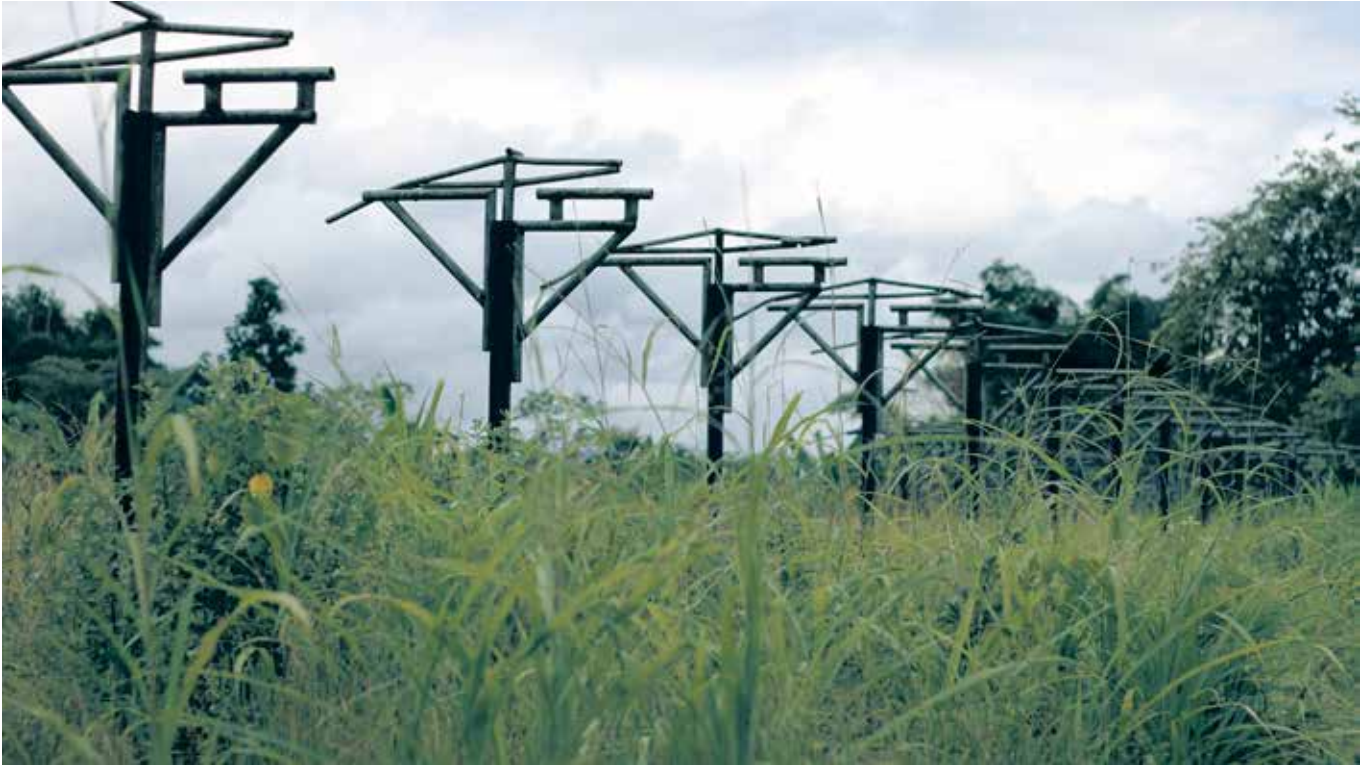
Instalaciones de la United Fruit, hoy abandonadas, en Palmar Sur, Costa Rica. Foto: Zuirí Méndez
