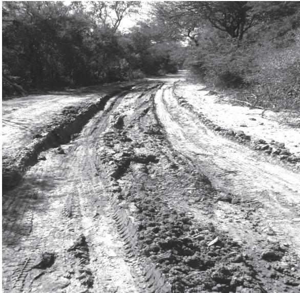
Las sendas comunitarias destruidas por el paso de camiones con rollizos AM 11:22 ABR/26/2014
