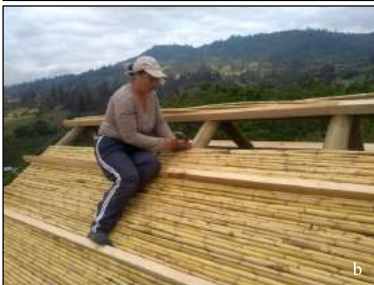
a) Sandra criando uma artesanato cor índigo trançado em paja blanca; b) Sandra construindo um telhado em chusque; c) montagem do telhado terminada. Fonte: a) acervo da autora (2019); b-c) concedidas por Sandra.
