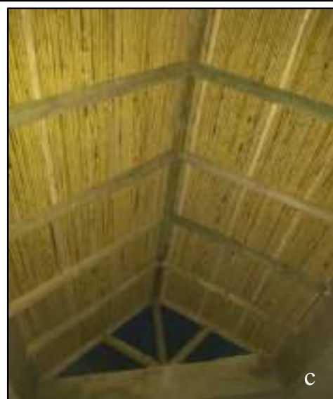
a) Sandra criando uma artesanato cor índigo trançado em paja blanca; b) Sandra construindo um telhado em chusque; c) montagem do telhado terminada. Fonte: a) acervo da autora (2019); b-c) concedidas por Sandra.
