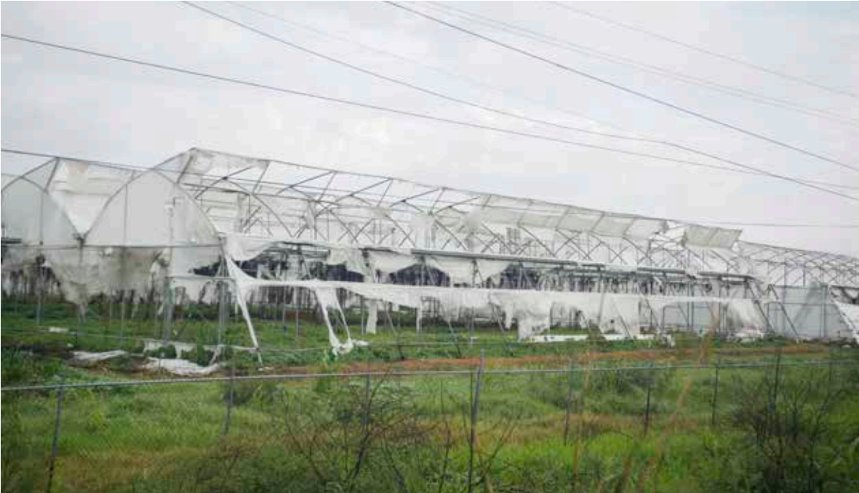
Construções abandonadas de estufas utilizadas para a produção de pequenas frutas. Ejido Villa Corona, Jalisco, México. Foto: Jerónimo Palomares
