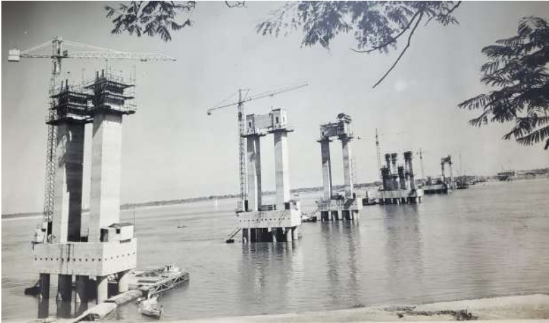
Fotografía 1. Construcción puente Gral. Belgrano
