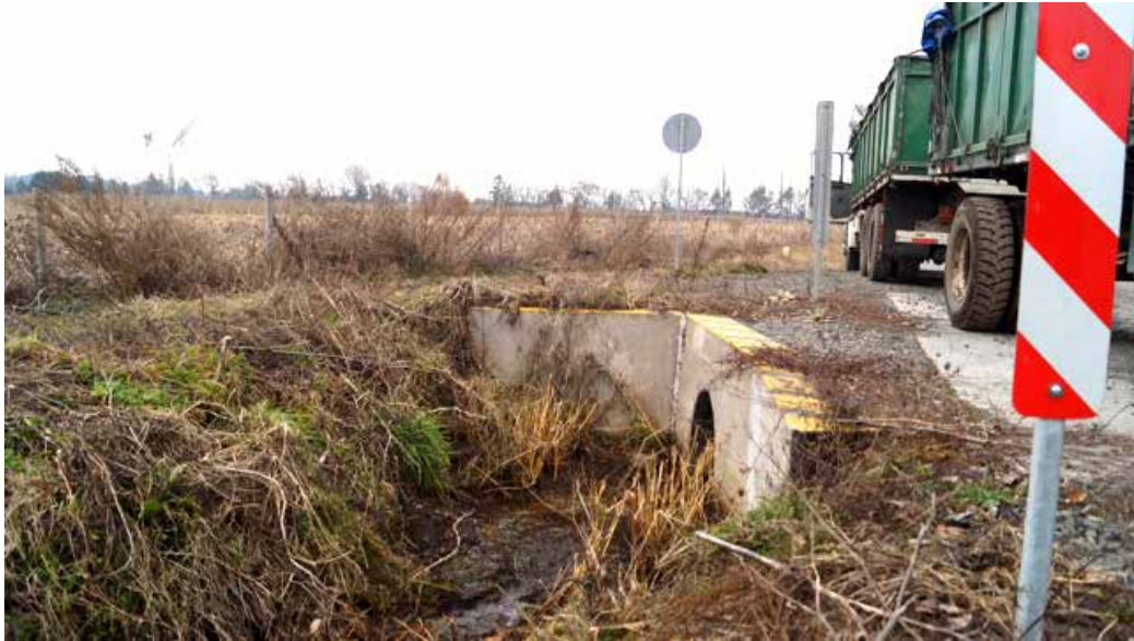
FIGURAS 11 Y 12: Intervenciones a bocatomas de canales de regadío para instalar cables soterrados
