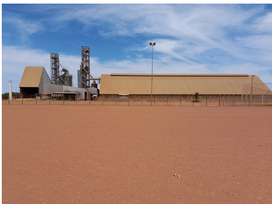
Silos da Bunge e Cargill, lado a lado, na região do Coaceral, em Formosa do Rio Preto.
